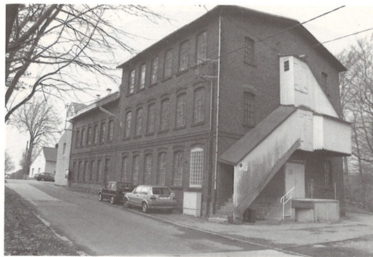
Abb. 8: Mietfabrik Schwelm, Obernhagen, Bandwirkerweg 44
