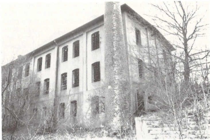
Abb. 6: Ruine der Mietfabrik Gennebreck-Herkamp, Elberfelder Straße Die gegen Ende des 19. Jahrhunderts erbaute, nach einem Brand 1911 wieder aufgebaute, große, 2 1/2 geschossige Mietfabrik ist mit ihren zahlreichen Sprossenfenstern und ihrem flachen Satteldach von ihrem Phänotypus her eine typische Mietfabrik.
