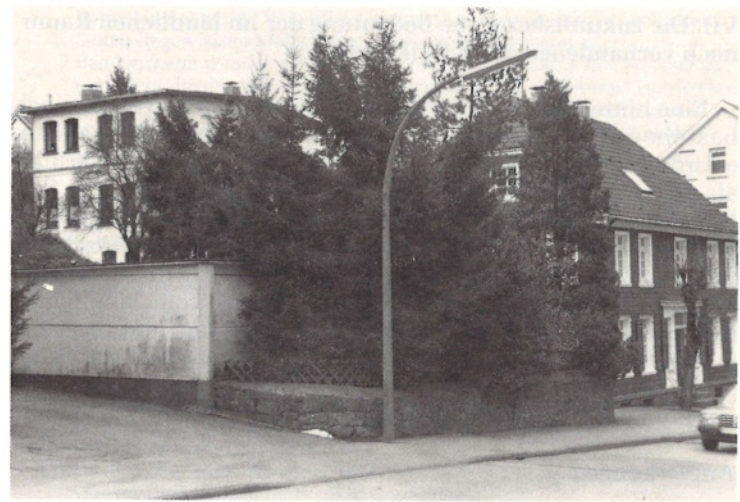
Abb. 10: Mietfabrik Schwelm, Kölner Straße 58b Der im linken Teil des Bildes erkennbare, am Hang gelegene, dreigeschossige, unverputzte Backsteinbau mit flach geneigtem Satteldach und großen, gereihten Segmentfenstern wurde 1890 am äußersten Südrand des seinerzeit verstädterten Gebietes von Schwelm im Hof des schon länger bestehenden, verschieferten Fachwerk-Wohnhauses am rechten Bildrand im Anschluß an einen von den Bäumen verdeckten, niedrigeren, älteren Zwischenbau, in dem schon einige Jahre Hausbandwirkerei betrieben worden war, im Zuge der Expansion der Hausbandwirkerei-Mietfabriken im Schwelmer Raum als eine solche Mietfabrik errichtet, in der von einer zentralen Antriebsmaschine die Energie über Transmissionen zu den einzelnen "Kraftstellen" übertragen wurde. Die ehemalige Mietfabrik diente bis in die 70er Jahre des 20. Jahrhunderts der Bandherstellung. Nach deren Aufgabe und nach einem Umbau, der in der jüngsten Vergangenheit erfolgte, hat sie seit kurzem unter Wahrung ihres grundsätzlichen Erscheinungsbildes eine neue, angemessene Funktion erhalten: Sie dient nunmehr als relativ ruhig gelegenes, städtisches Wohnhaus. Dazu ist sie auch von außen weiß gestrichen worden. Foto: D. Beckmann, März 1992
