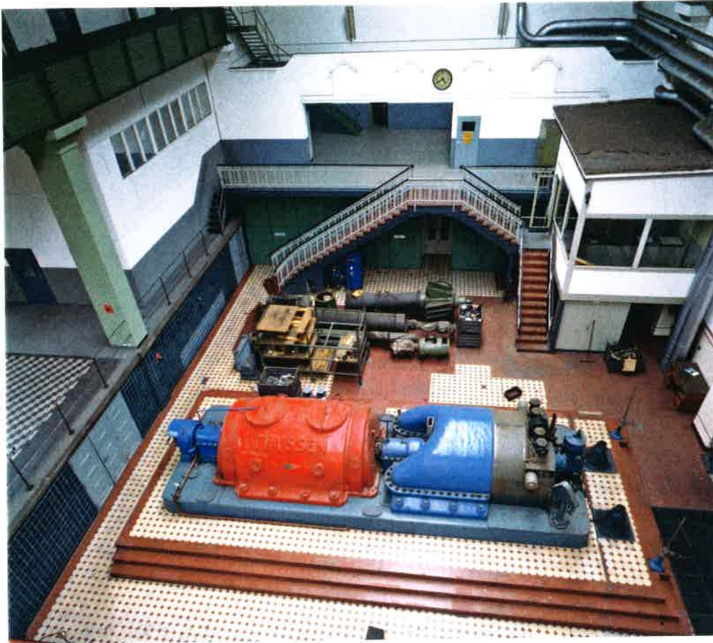
Das Gevelsberger Kraftwerk war auch architektonisch eine Besonderheit. Nachdem die letzte Maschine 1976 abgestellt wurde, wurde ein Jugendstilgeländer in das Hagener Freilichtmuseum gebracht, bevor der Abbruch begann. Foto: Detlef Sauerborn
