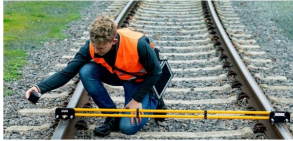
Messung der Spurweite an Eisenbahngleisen 85, 86
