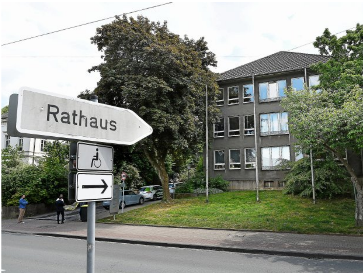
Unter dem Dach des Rathauses in der Hauptstraße 14 ist das neue Amt des Bürgermeisters zu finden. Foto: Bernd Richter / WP
