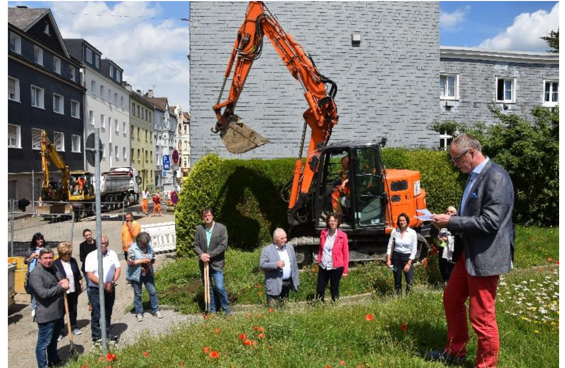
Zum Spaten griffen symbolisch Architekt Andreas Schaub, Stadtplaner Niklas Lippki, Projektleiter Thomas Striebeck und Stefan Selle von Projektsteuerer Assmann. Fotos: Heike Rudolph
