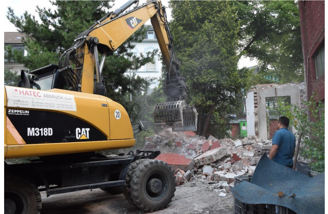
Abriss der zum Neumarkt hin gelegenen Trafostation der früheren Schwelmer Brauerei. Foto: Stadt Schwelm/Heike Rudolph
