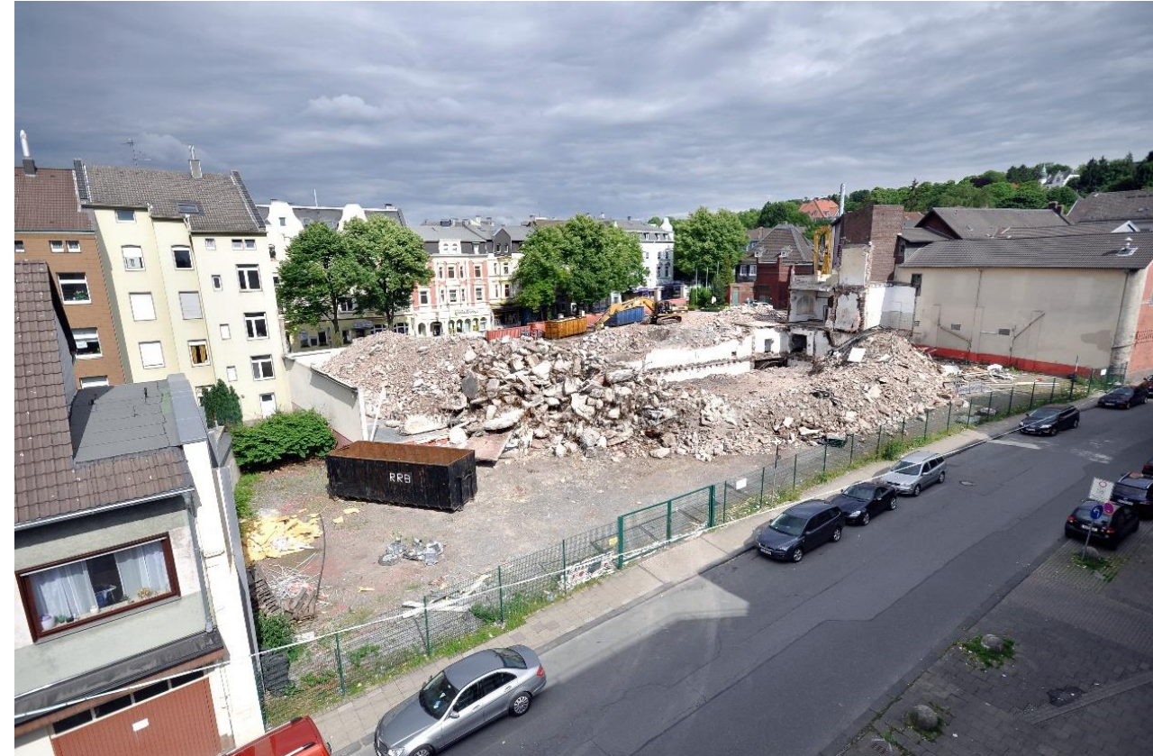
Blick auf das Gelände der ehemaligen Schwelmer Brauerei. Die Pass-Invest, die das Grundstück 2012 erworben und später wieder veräußert hatte, hatte die nicht denkmalgeschützten Gebäudeteile abreißen lassen. Foto: Stadt Schwelm/Heike Rudolph
