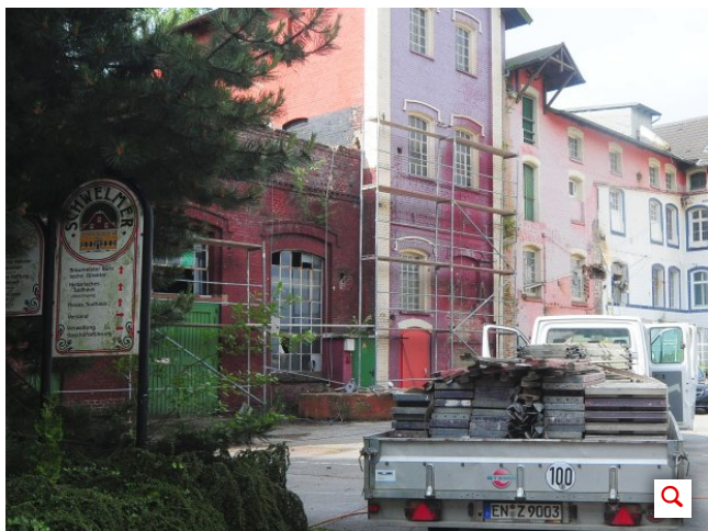
Aktuell rüstet die Firma Ziebs das Kesselhaus ein. Foto: Stefan Scherer
