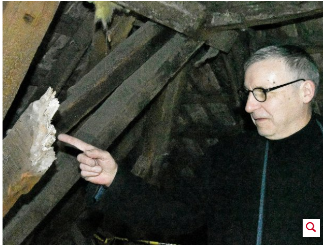
Architekt Klaus Lange zeigt auf einen gebrochenen Sparren im Dachgeschoss. Foto: WP / Bernd Richter
